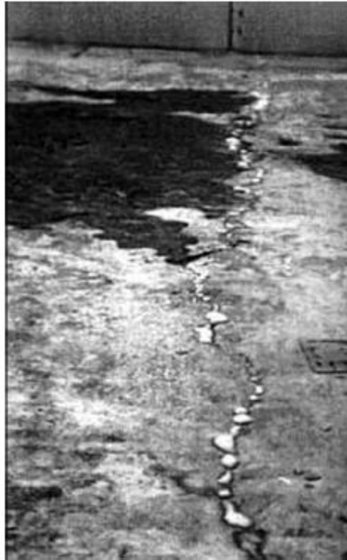
*Fotografia do preenchimento da fissura com o adesivo de reparo incorporado no concreto do pavimento de ponte (DRY, 2000, p. 1975)*
